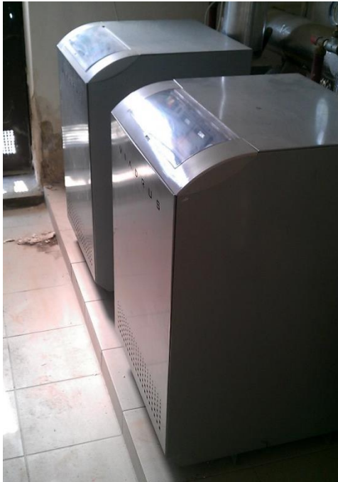
Obrázok 20 Kotle VIADRUS G 42 ECO
