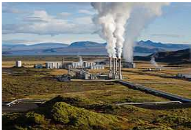
Obr. 11 Geotermální elektrárna v Nesjavellíru na Islandu [35]
