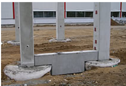
Obr. 5-6 Osazení základového prahu [53]
