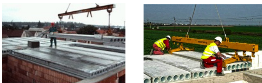
Obr. 5-2 Montáž panelů Spiroll pomocí samosvorných kleští [57], [58]
