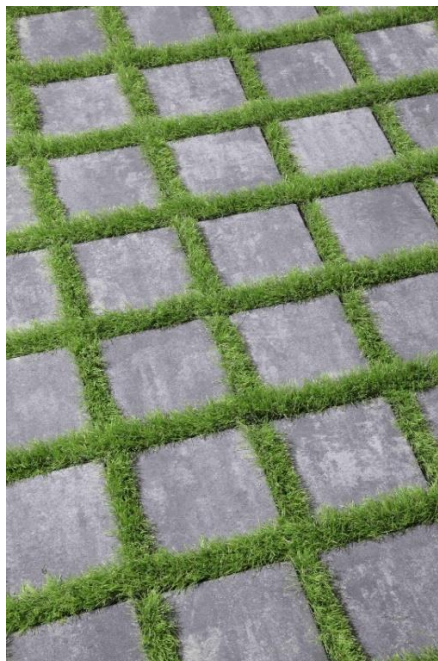
Obr. 31 Betonová distanční dlažba pro pojiždění autem [5]
