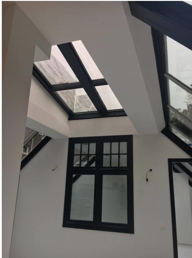
Obr. 8: Ukážka výmeny okien a ich finálna úprava (interné zdroje spoločnosti)
