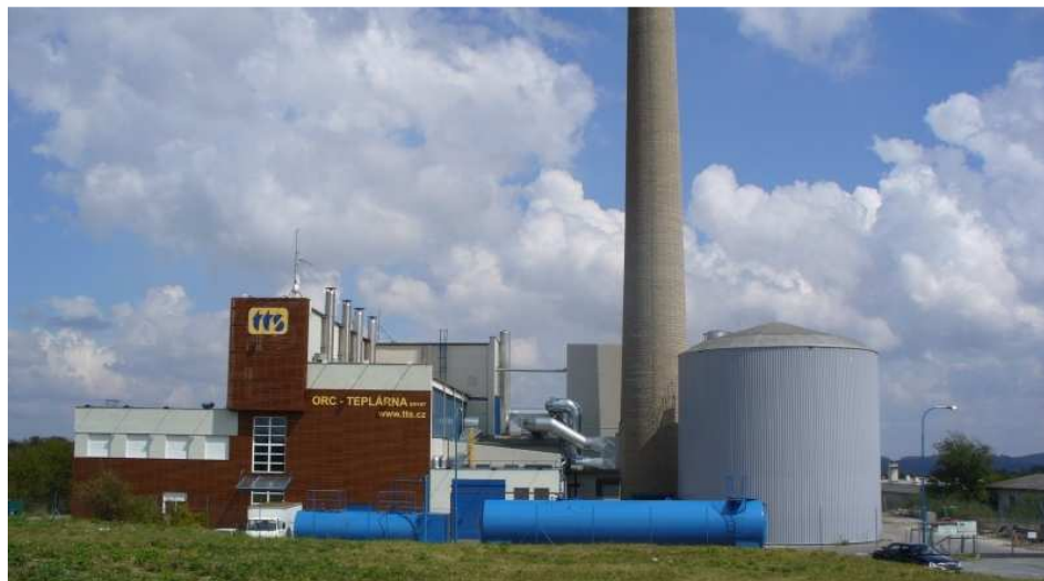
Obr. 14 Teplárna v Třebíči [14]
