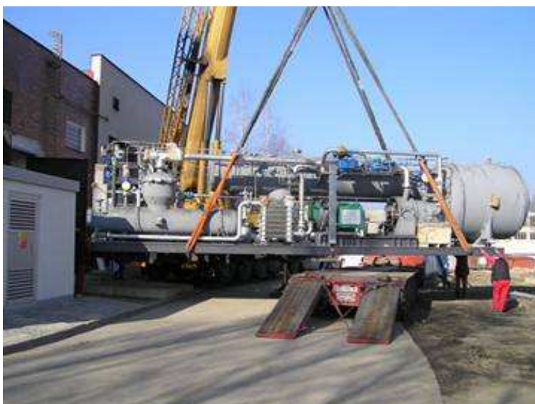
Obr. 13 ORC jednotka při montáži [16]
