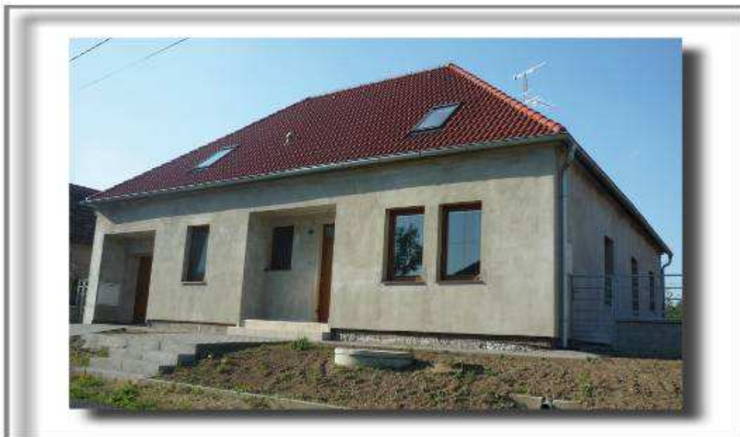
Obrázek č. 18: Čelní pohled rodinného domu 6 (Popice u Znojma)
