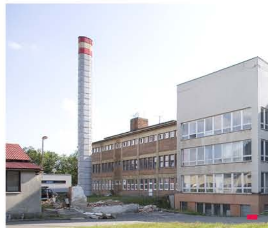
Komín z betonových tvárnic
