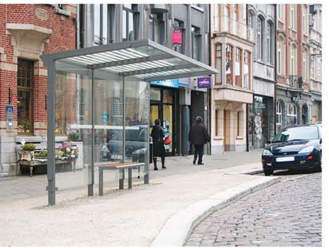
AUTOBUSOVÁ ZASTÁVKA ocelová zinkovaná konstrukce opatřena práškovým vypalovacím lakem. Zadní stěna a zastřešení z kaleného skla. Odvodnění vedené nohou. Součástí zastávky je lavička z masivního dřeva
