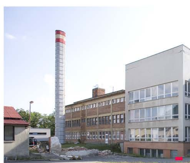
⑧ Komin z betonových tvárnic
