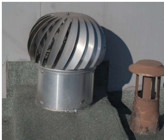
Obr. B.17 Větrání objektu nad střechu
