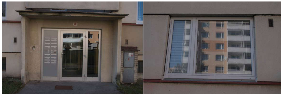
Obr. B.11 Vyměněné výplně otvorů
