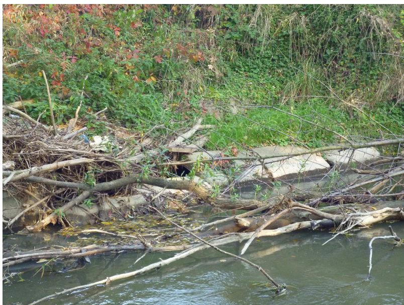
Obr.2.11 Zaústění místní vodoteč na km 6,095
