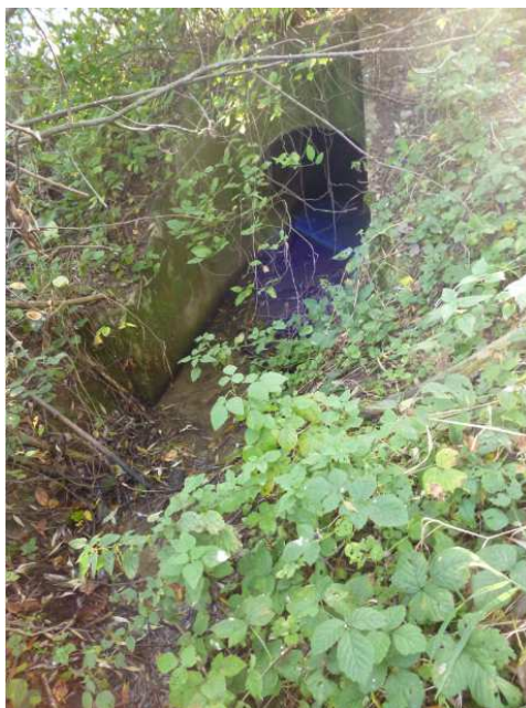
Obr.2.10 Zaústění místní vodoteč na km 5,698
