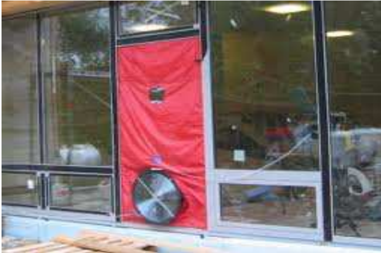
Obr. 1.5 Ukázka techniky Blower – door testu
