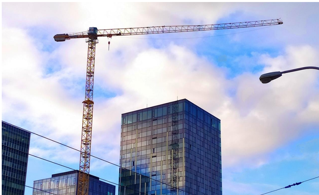
Obrázek 1 Foto jeřábu 150EC-B8 Litronic na ulici Šumavská, Brno
