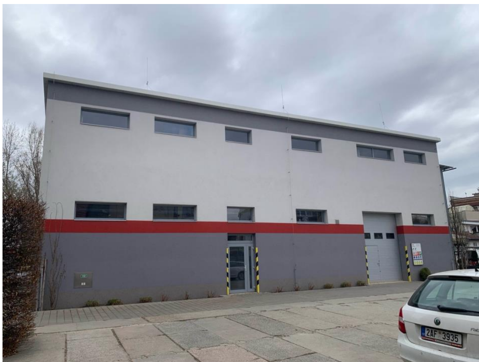
Obrázek 1 - Budova nových skladů
