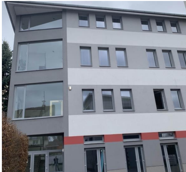
Obrázek 3 - Budova výzkumného střediska
