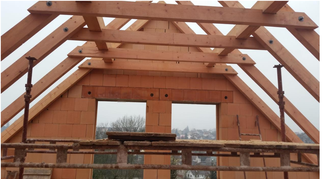
Obr.3 Konstrukce krovu
