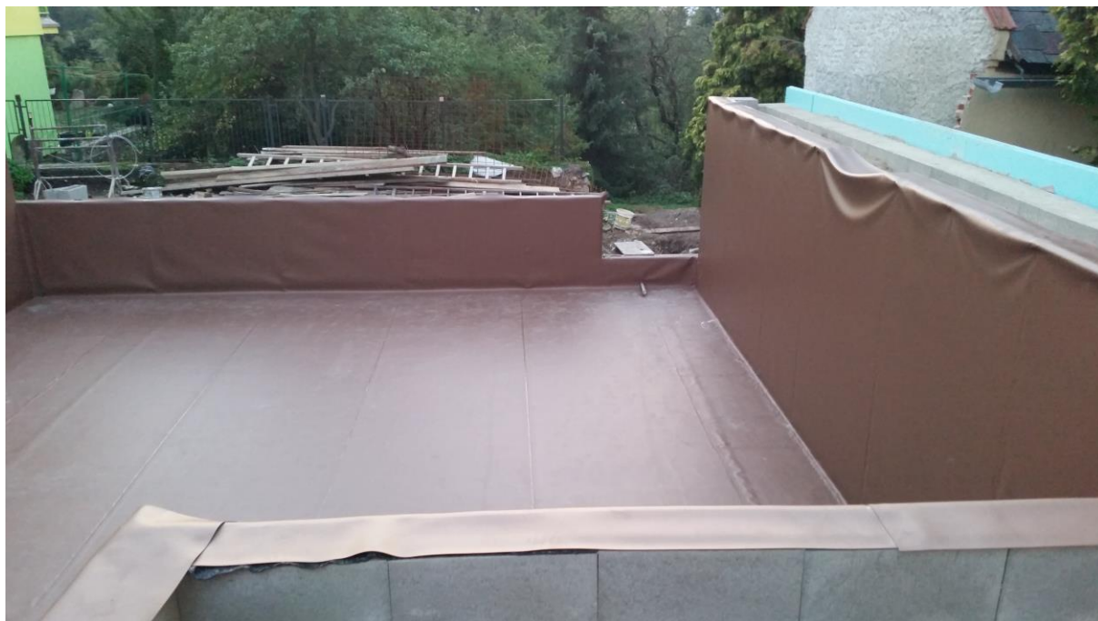
Obr.2 Provedení hydroizolace
