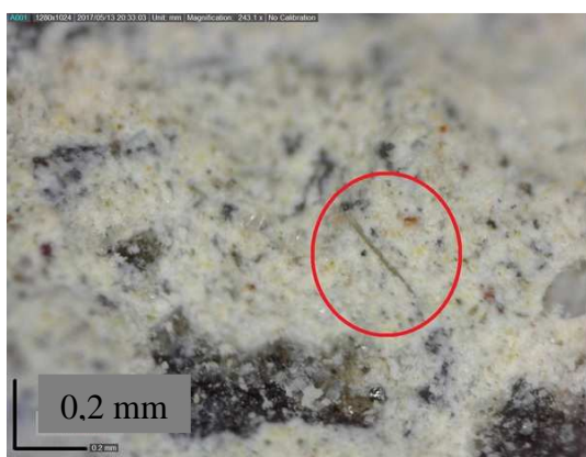
Obrázek č. 18 – Beton vystavený teplotě 400 °C, červeně vyznačeno čedičové vlákno
