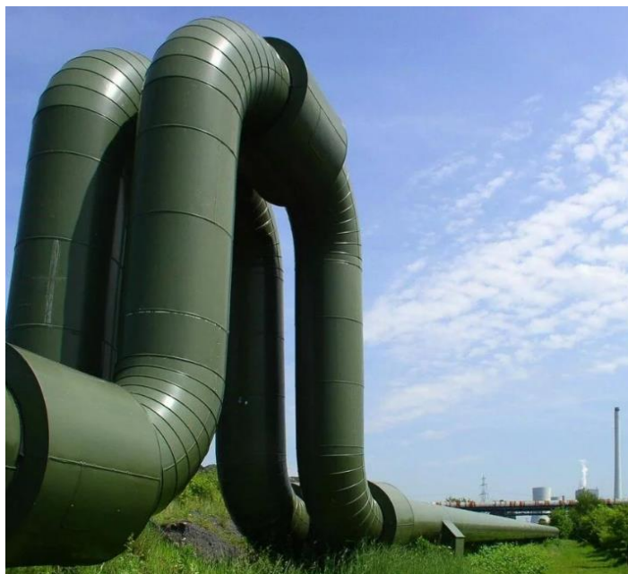
Obrázek 3: Nadzemní potrubí druhé generace[9]
