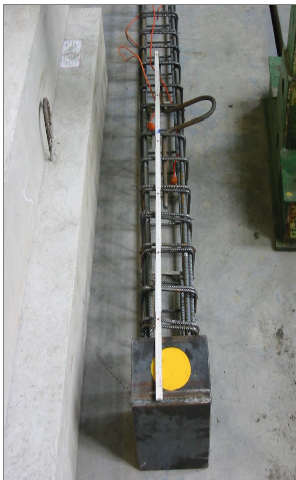
Obr. 3 – čelní ocelová krabice svařená s armokošem
