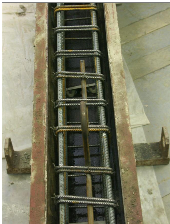
Obr. 8 – armatura v bedně
