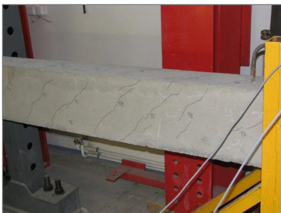
Obrázek 7-18 Vznik trhlin N3 – 1
