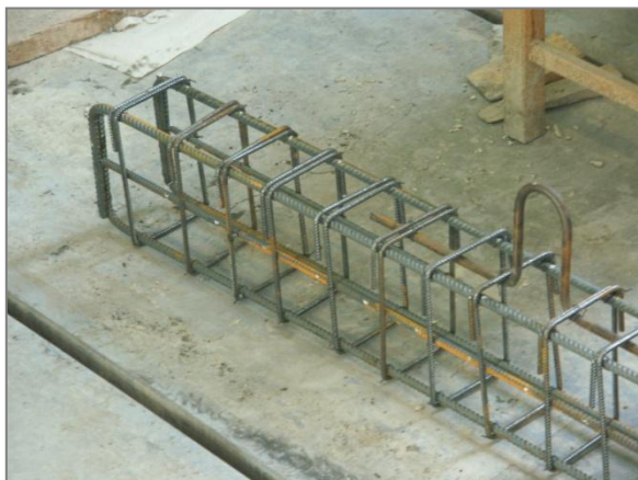
Obr. 1 – vyvázaný armokoš
