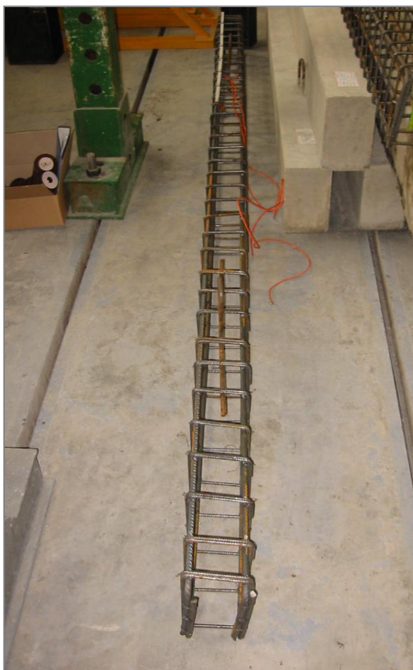
Obr. 4 – vyvázaný armokoš
