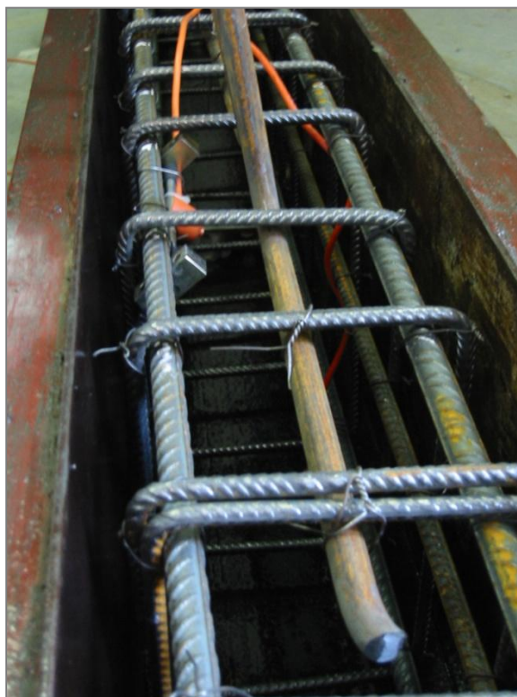
Obr. 7 – detail vyvázaných třmínků
