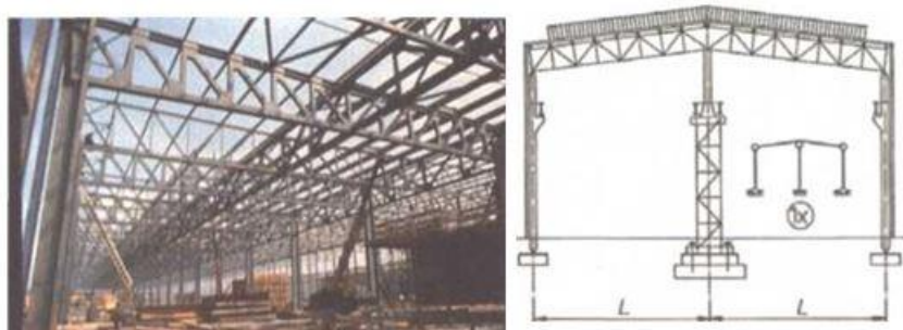
Obr. 1.8. Hala s priehradovými väzníkmi a plnostennými stĺpmi [1].
