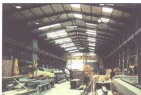
Obr. 1.6. Staticky určitá trojklbová priečna väzba [1].
