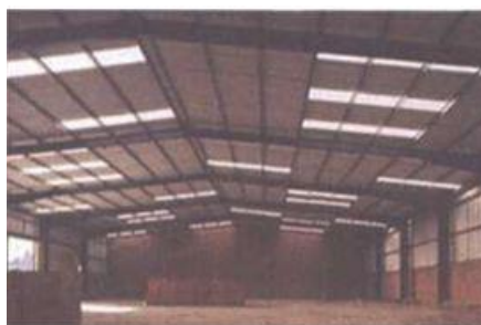
Obr. 1.3. Rámová priečna väzba skladovacej jednoloďovej haly [1].
