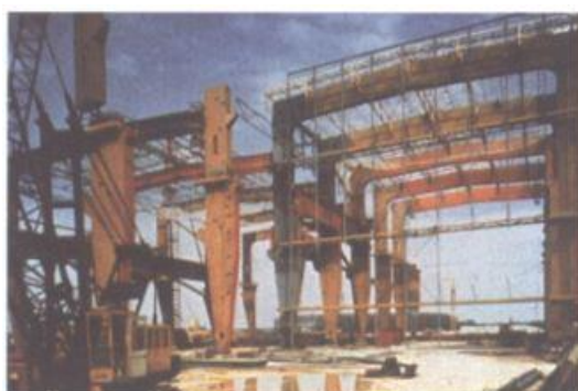
Obr. 1.12. Hala s kĺbovo uloženým stĺpom priečnej väzby na základ [1].
