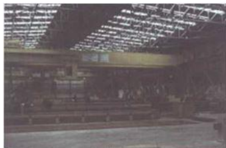
Obr. 1.4. Halový jednolod'ový objekt so stĺpovou priečnou väzbou a priehradovou priečlou obsluhovaný žeriavmi [1].
