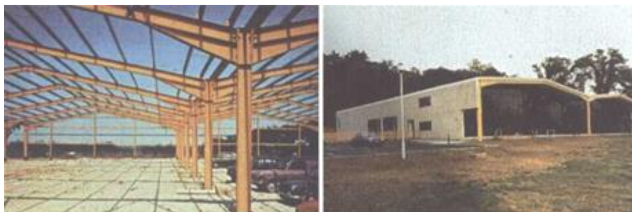
Obr. 1.7. Hala s dvorná loďami v priebehu výstavby a po dokončení [1].
