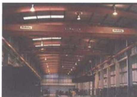
Obr. 1.5. Jednolod'ová hala so stĺpovou priečnou väzbou a plnostennou priečlou [1].
