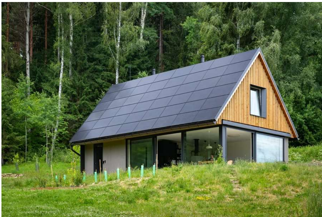
Obr. 1 – První energeticky soběstačný dům v ČR [5].
