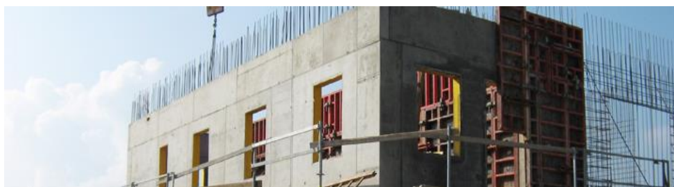
Obrázek č. 6-5: Bioplynová stanice Radešínská Svratka [31]
