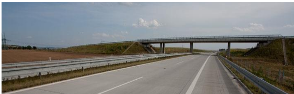
Obrázek č. 6-1: Dálnice D1, stavba 0135 Kroměříž - východ – Říkovice [31]
