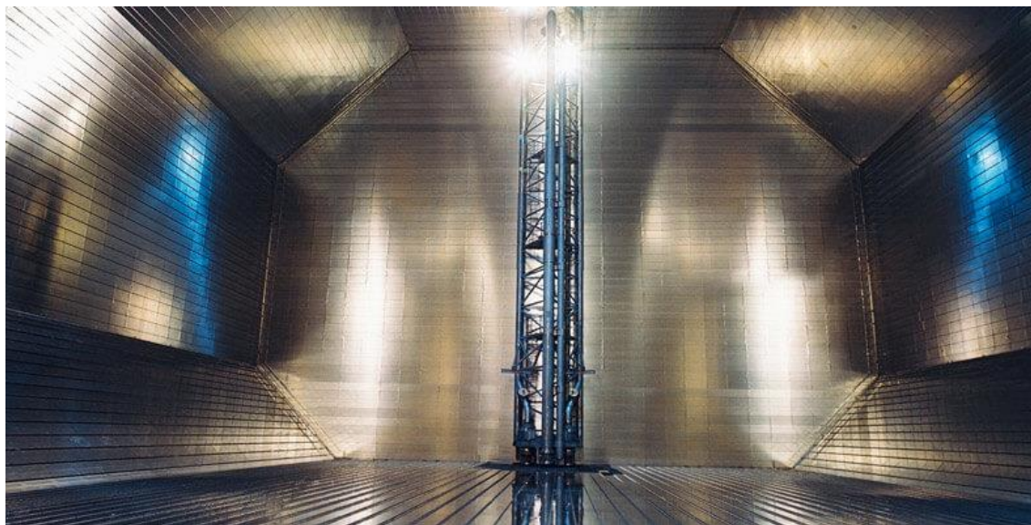
Obr. 3: Uvnitř nádrže provedení GT96[53]
