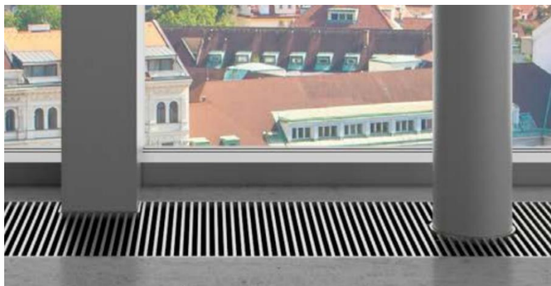
Obrázek 20: Příklad napojení konvektoru na sloup [12]
