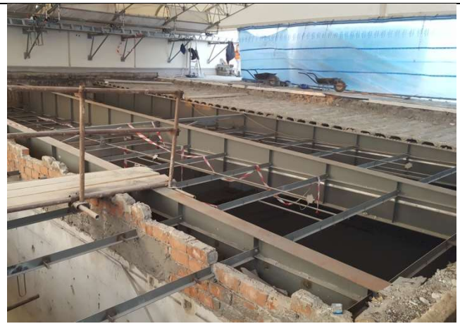
Plnostěnný ocelový vazník
