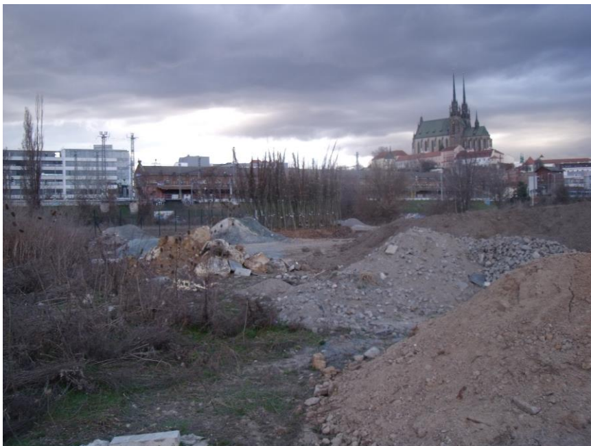
Staveniště na rohu ulic Úzká a Uhelná - 1. lokace, Brno
