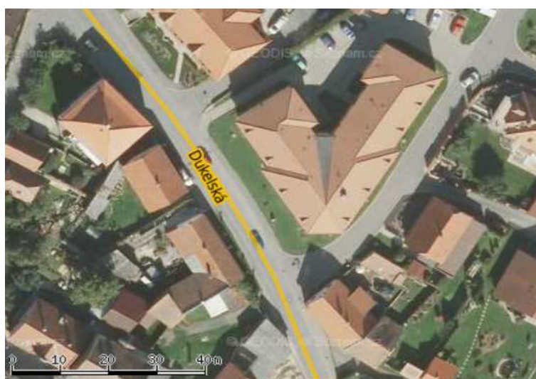
Obr. 2. Letecký pohled na řešenou budovu
