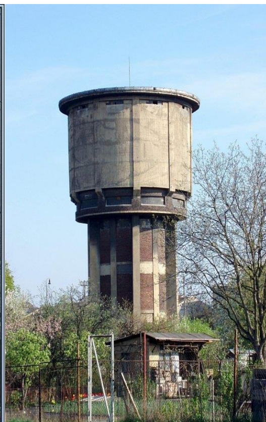
Obr. 3.3 Drážní vodojem v Přerově [6]
