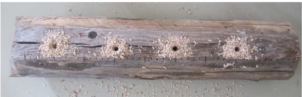
Obr. 34 Vrty provedené na prvku
