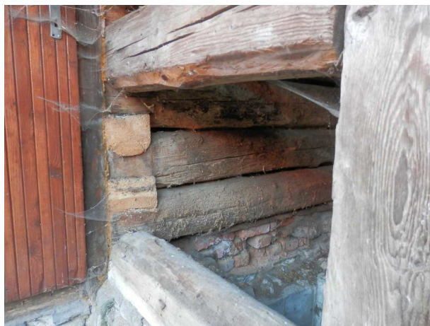
Obr. 28 Místo odebrání prvku v konstrukci
