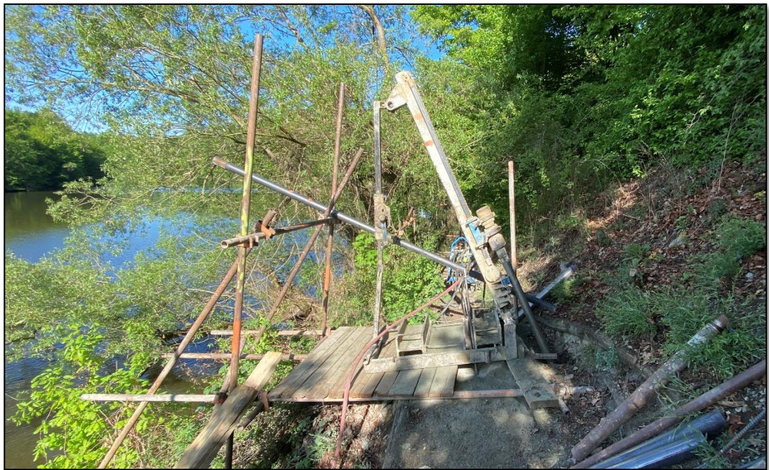
Obrázek 15: Souprava pro vrtání mikropilot [Vlastní fotografie (12.5.2020)]
