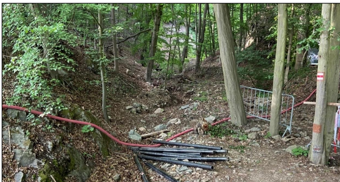
Obrázek 16: Původní stav koryta potoka [vlastní fotografie (26.5.2020)]
