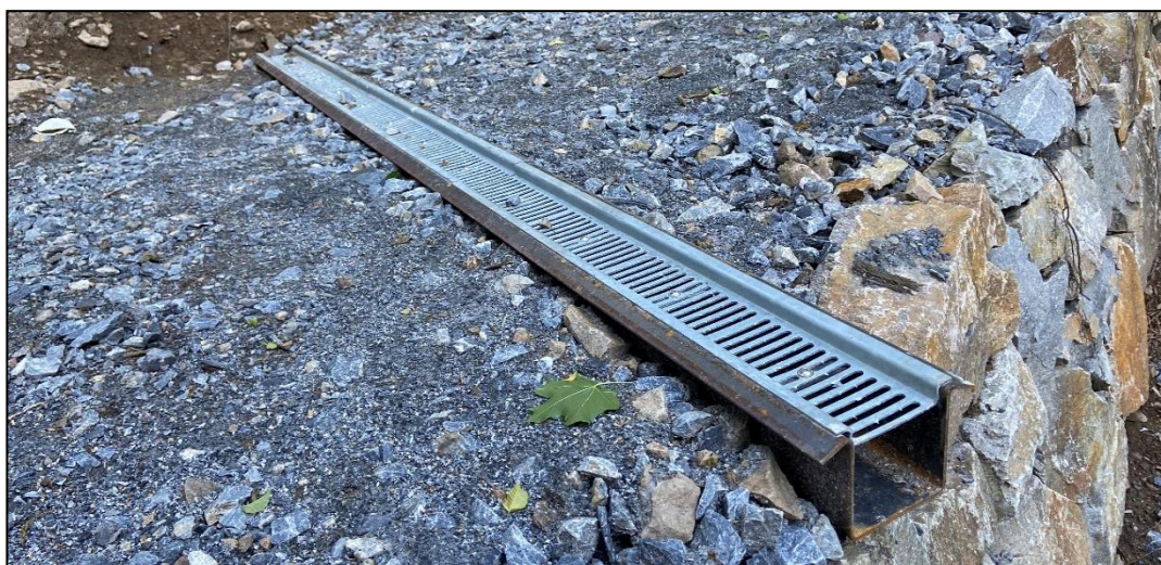
Obrázek 14: Osazená svodnice [vlastní fotografie (26.5.2020)]
