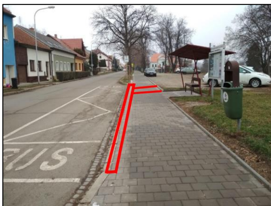
Obr. 39 Hmatové úpravy autobusové zastávky Šlapanice – železniční stanice
