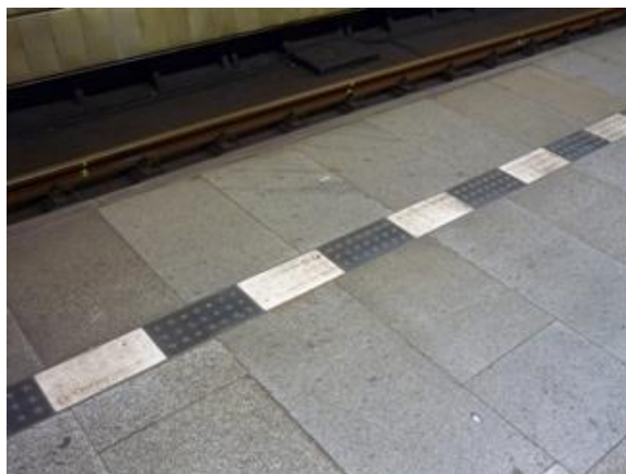
Obr. 17 Varovný pás na nástupišti metra [5]
