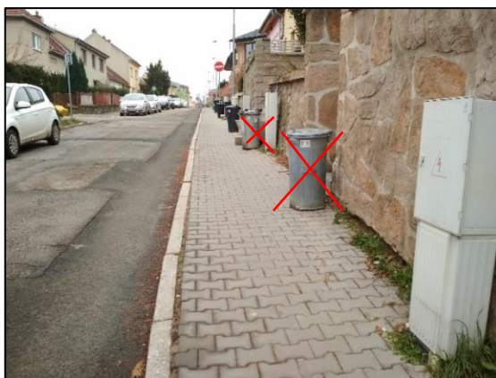
Obr. 86 Ulice Komenského – odstranění překážek
