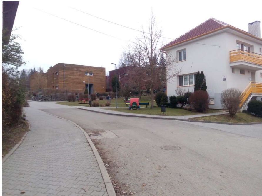
Obr. 12 Pohled od vjezdu do vesničky. Vpravo bílý dům č. p. 506/9 (únor 2018)
