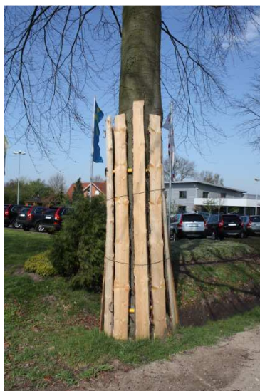
Obr. 11.2. Ilustrační fotografie dřevěného bednění kmene stromu.
