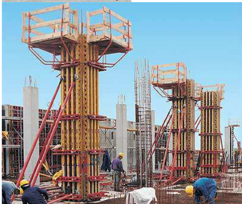
Obr. 9.1. (vlevo) Ilustrace hotového bednění sloupu.
