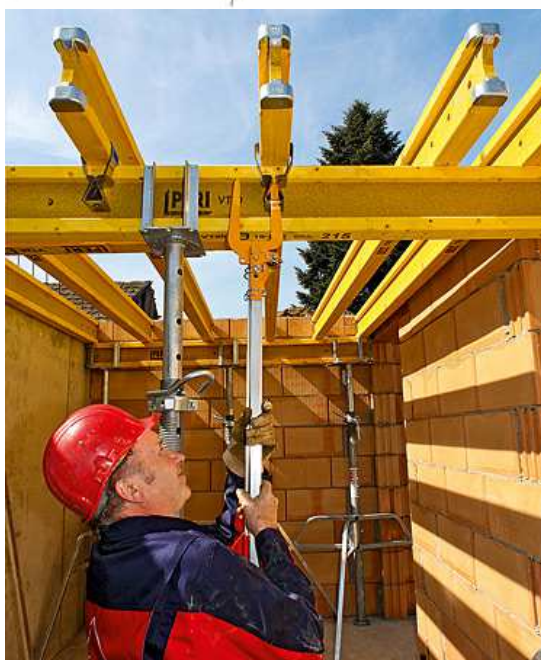
Obr. 9.3.(vlevo) Vizualizace stropního bednění.
