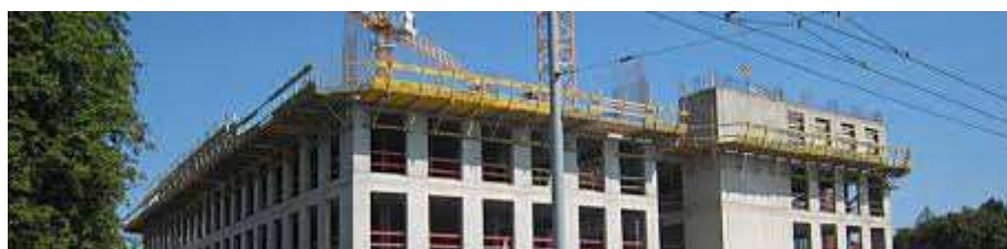
Obr. 9.1. Ilustrační foto železobetonové monolitické konstrukce
