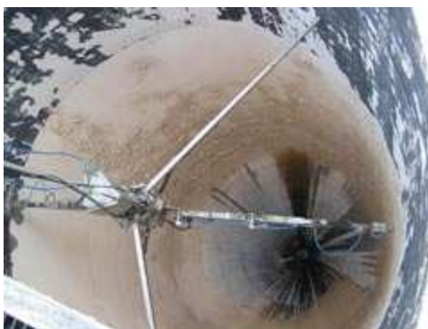
Obr. 4.4 Příklad aplikace zařízení pro čištění nádrží vysokotlakou vodou (29)
