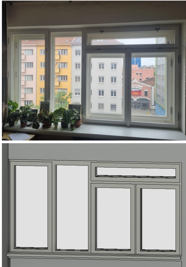
Obr. 5.5: Porovnanie skutočného stavu a vymodelovaného stavu vybranej časti okna [Autor]
