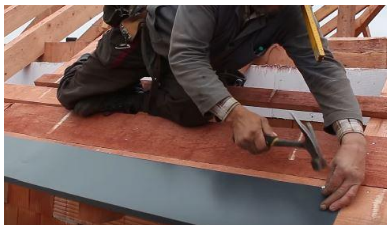
Obr. 3.12: Ukázka uchycení okapního plechu Zdroj: http://www.svepomoci.cz
