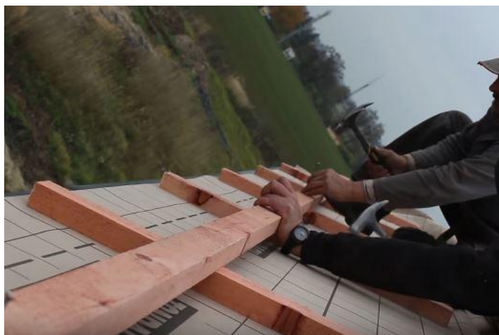
Obr. 3.13: Ukázka přibití střešní latě Zdroj: http://www.svepomoci.cz
