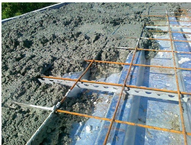
Obr. 3.8: Ukázka pokládky výztuže a distančních lišt Zdroj: http://www.kotaca.cz/podrubrika.php?ID=2
