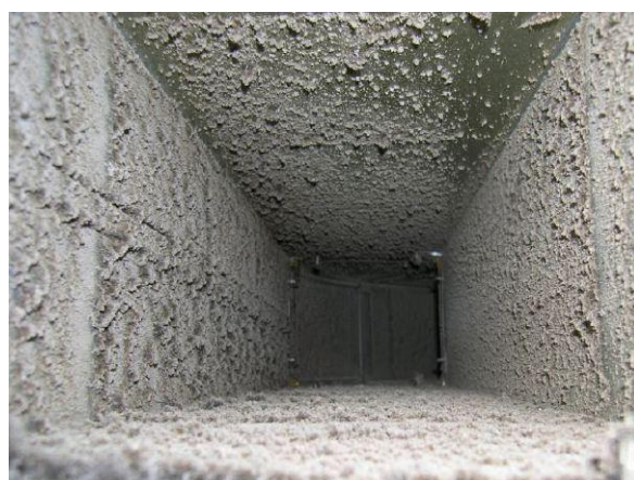
b) Znečištění hranatého přívodního potrubí
