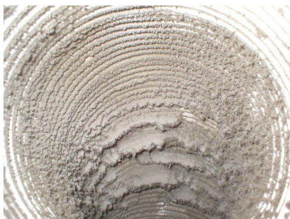
Obr. 24: a) Znečištění ohebné hadice odvodního vzduchovodu [41]
