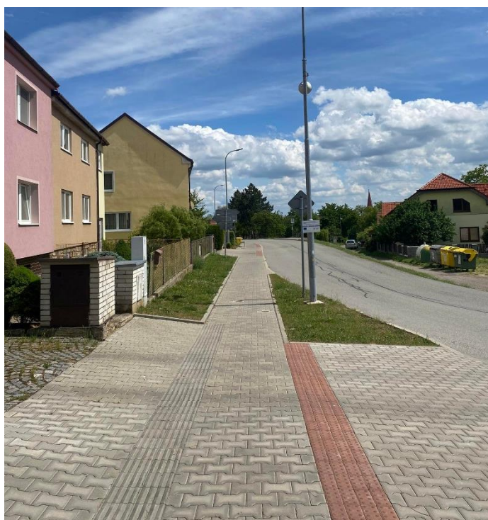
Obrázek 11 Nově vybudovaný chodník na ulici Větrov – Úsek I
