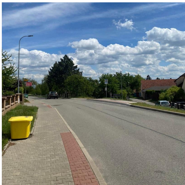
Obrázek 12 Nově vybudovaná autobusová zastávka na ulici Větrov – Úsek I
