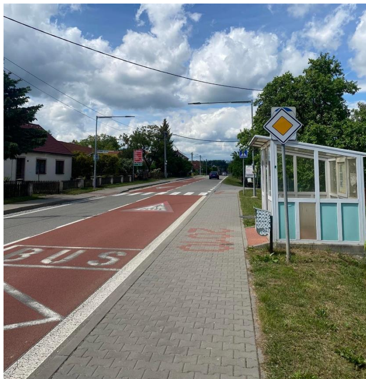
Obrázek 13 Nově vybudovaná autobusová zastávka na ulici Brněnská
