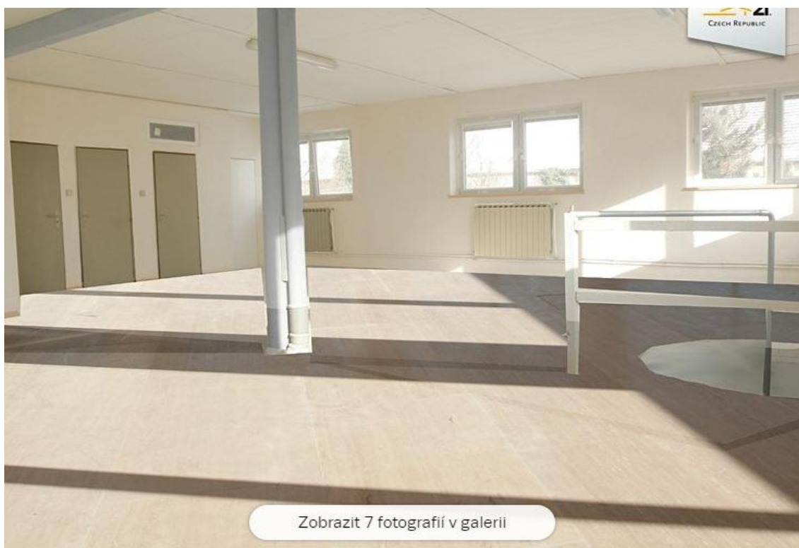
Pohled směrem k budoucím sociálním zařízením
