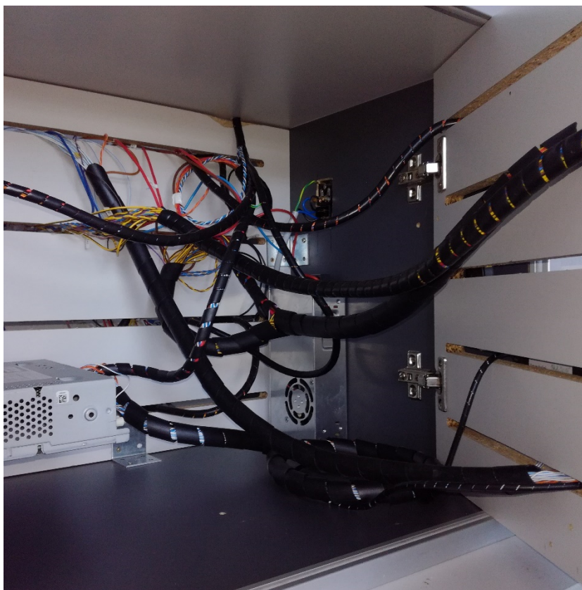
Obrázek 1.5 Elektrické svazky uvnitř testovacího standu
