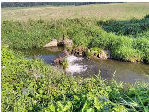
Obr. 36 - Úsek 2 – vzdouvací objekt
