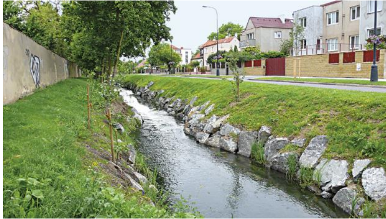
Obr. 12 - Revitalizované koryto v intravilánu, zdroj: casopis.ochranaprirody.cz , foto: Tomáš Just
