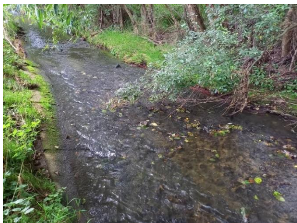
Obr. 40 - Úsek 3 – upravené koryto
