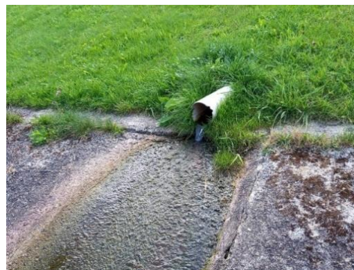
Obr. 67 - KÚ10 – Vtok do požární nádrže
