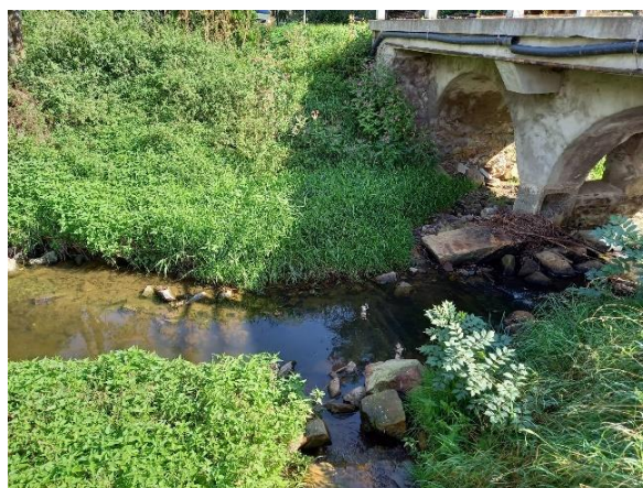
Obr. 39 - Úsek 3 - kamenný most
