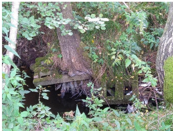
Obr. 6 - Narušení opevnění Libotyňského potoka dřevinami, foto: Bc. Jan Pikna
