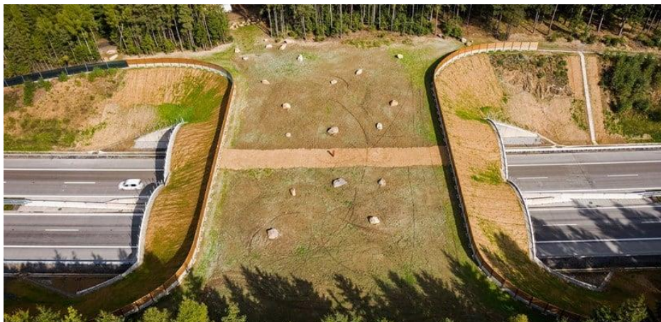
Obr. 22 - nově vybudovaný ekodukt na dálnici D1, zdroj: www.skanska.cz
