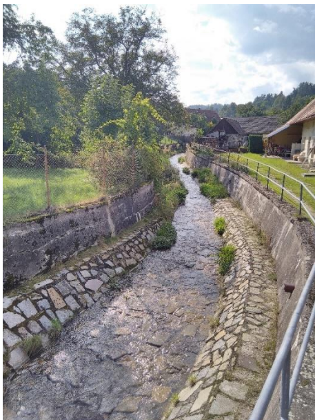
Obr. 46 - Úsek 5 - koryto s kamennou dlažbou
