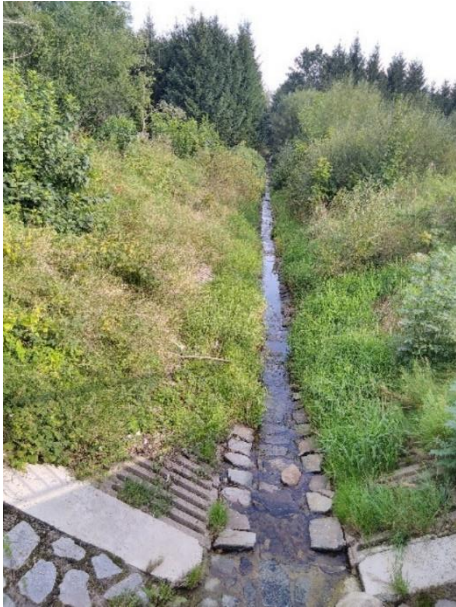
Obr. 42 – ZÚ4 - Pohled z mostu
