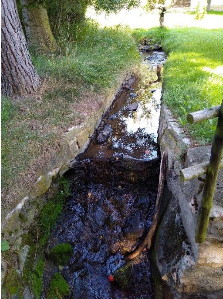
Obr. 57 - Úsek 8 – obdélníková úprava koryta
