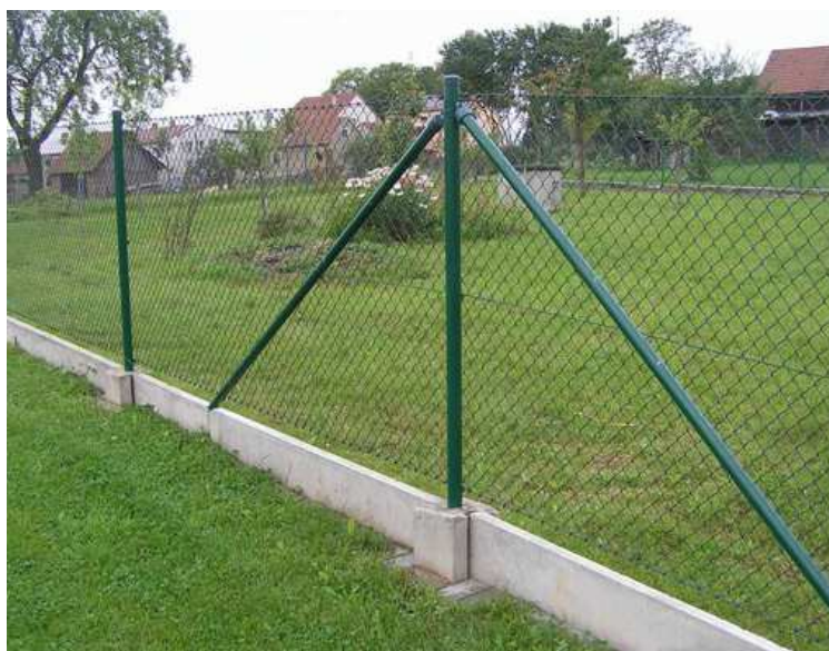
Obr. 1 – Pohled na oplocení staveniště
