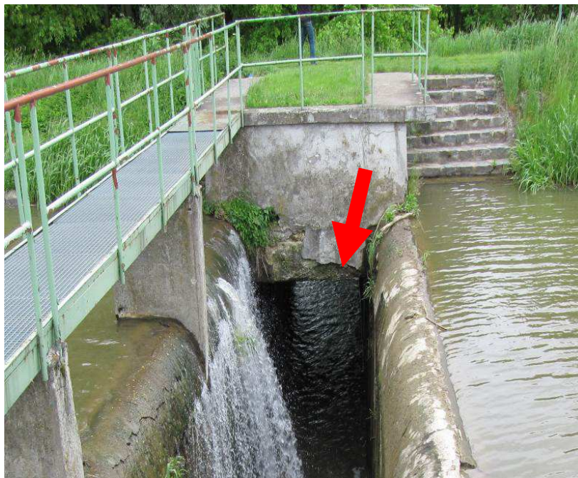
Obr. 4-1 Strop propustku pod úrovní hladiny stálého nadržení [18]
