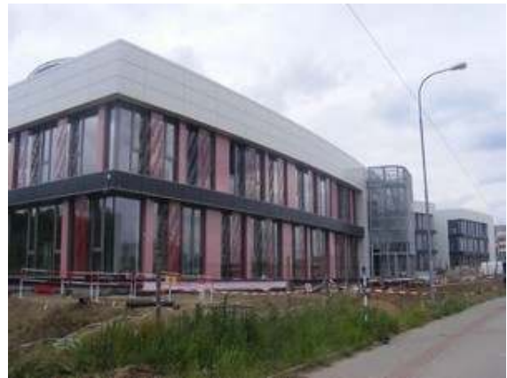
Obr. 14-2: Brno, Technologický park - výstavba
