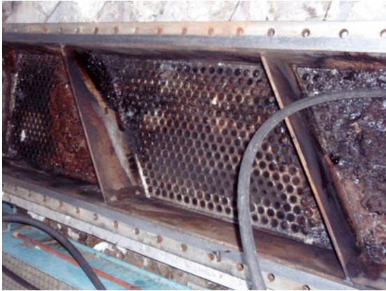
Obr. 6 Vstup PO do TP
