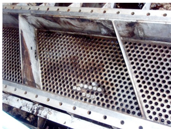
Obr. 11 Zaslepené trubky na vstupu PO do TP po vyčištění.
