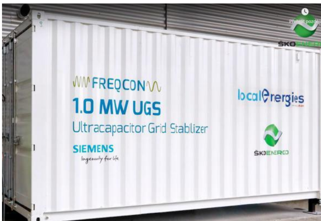
Obrázek 1.8 Ultrakapacitor o výkonu 1MW nacházející se v závodě Škoda Auto v Mladé Boleslavi.[19]
