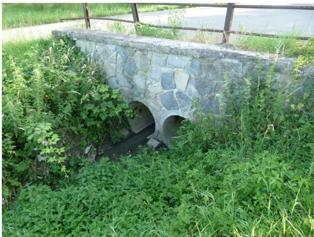
Obr. 3-10 Vyústění stávající dešťové kanalizace do otevřeného koryta [28]
