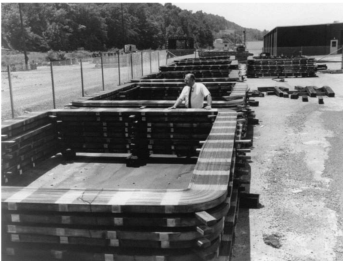
Příloha obr. 5 Cívky elektromagnetů calutronu [7]
