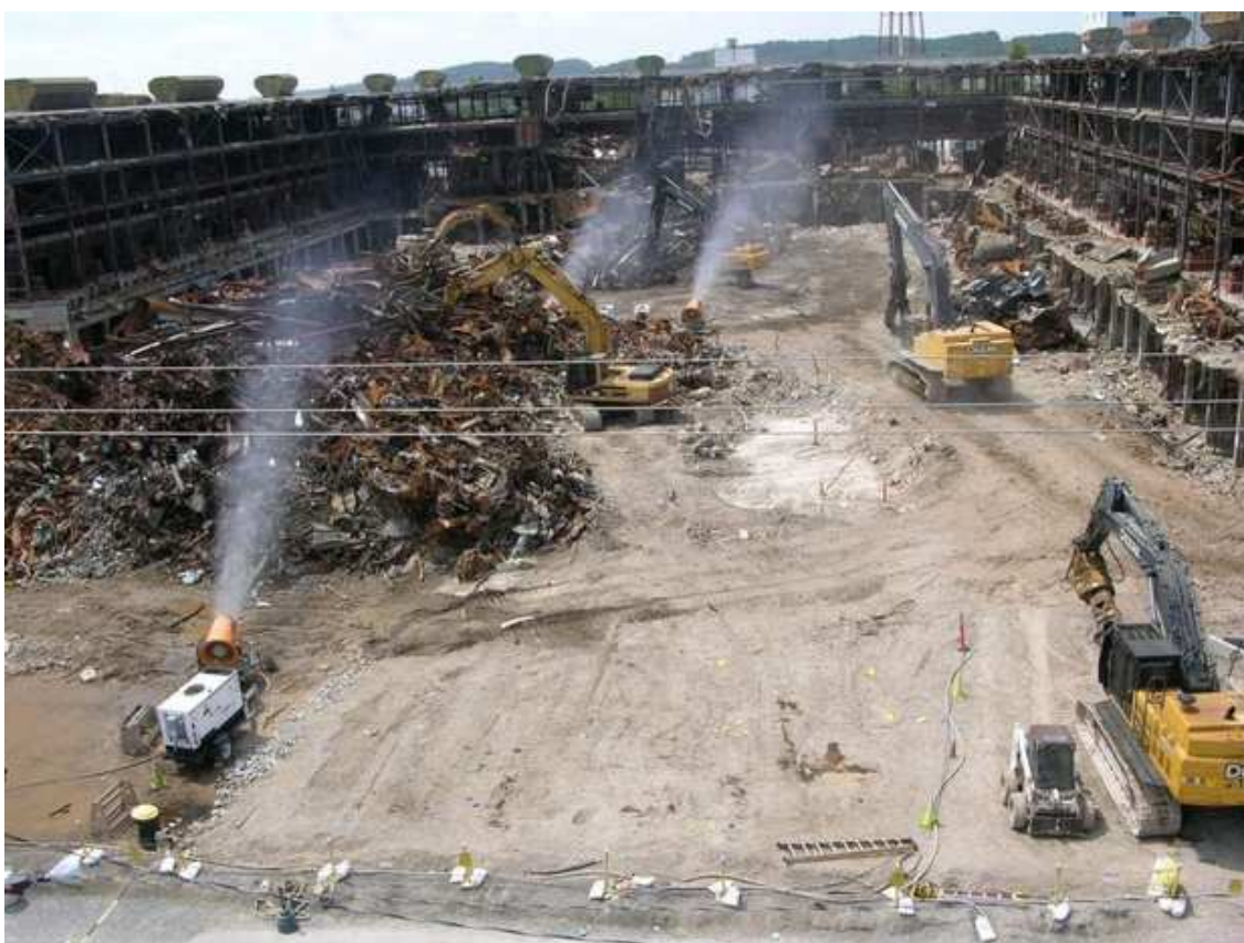
Příloha obr. 12 Demolice K-25 [27]
