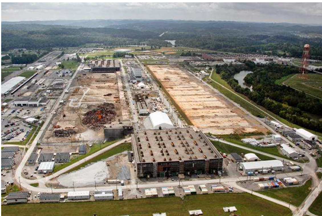
Příloha obr. 11 K-25 v demolici [27]
