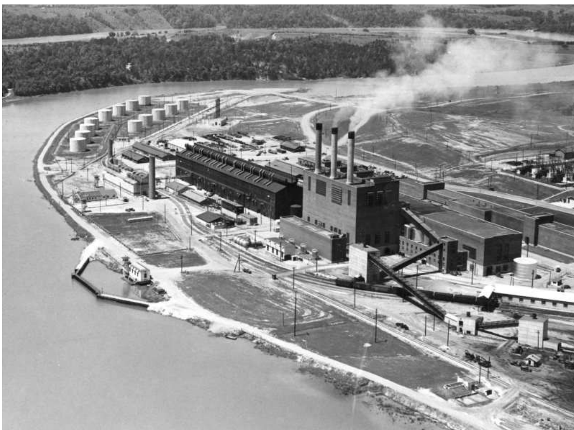
Příloha obr. 8 Budova S-50 [8]
