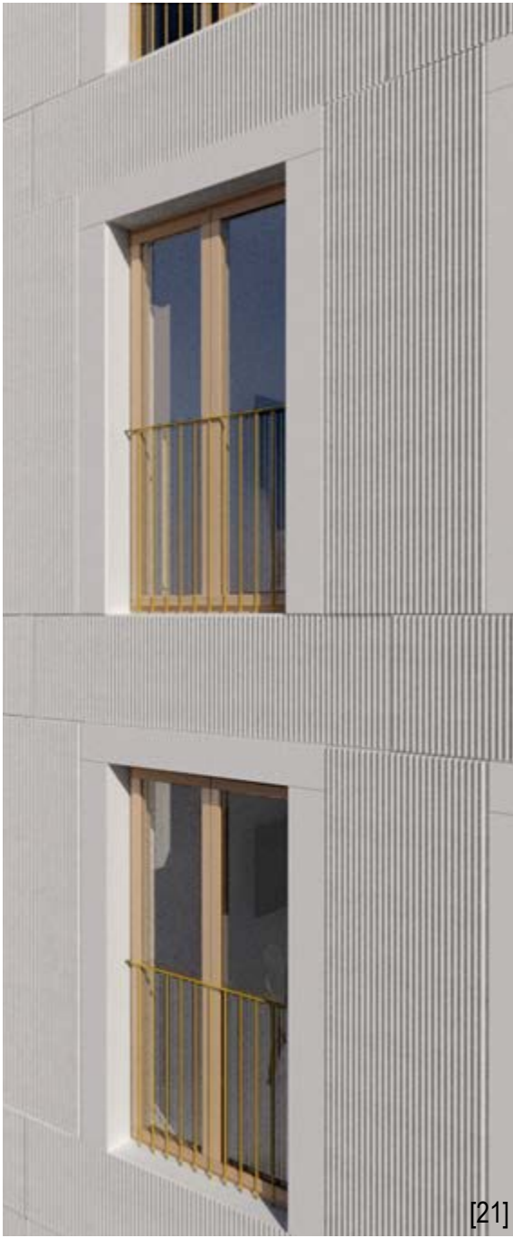
Dřevěná okna s ocelovým zábradlím
