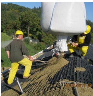
Obr.18: Ukázka manipulace s výkopkem
