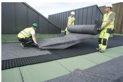
Obr.17: Ukázka kladení geotextílie
