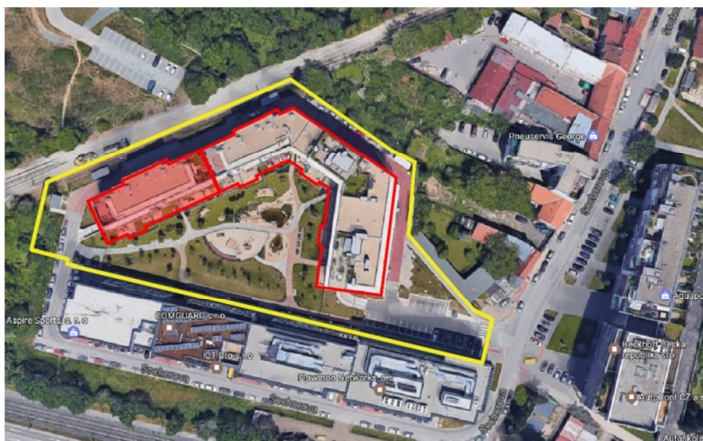
Obr.40: Náhled na staveniště
