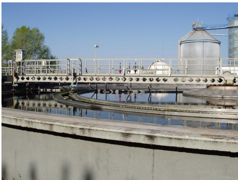
Obrázek 5: Dosazovací nádrž ČOV Hodonín [foto: Milan Herka]
